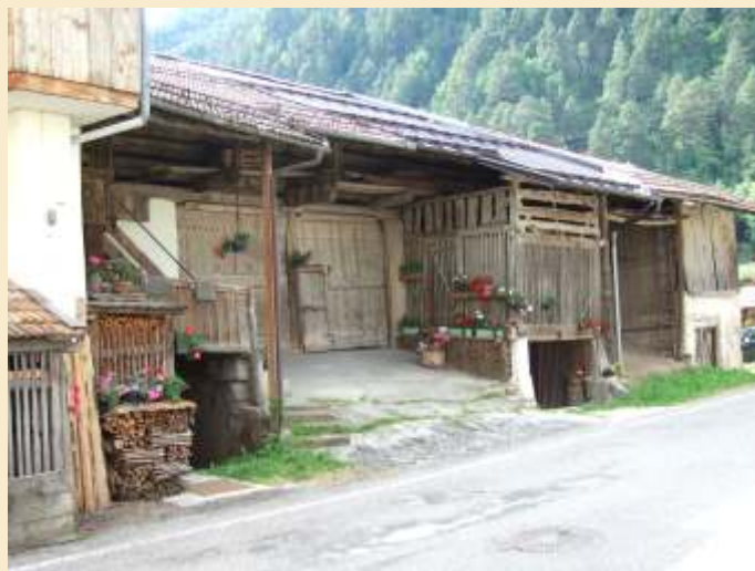
La parte rustica di una casa contadina con i pònti dé tabià , gli ingressi alle stalle e i pertegàri
