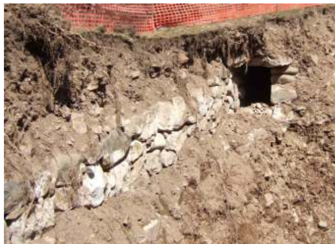
Gli scavi del 2009 hanno riportato alla luce il vecchio acquedotto
