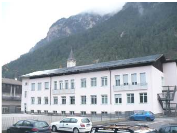
i pannelli solari sulla scuola elementare
