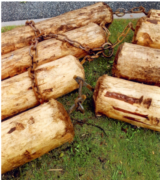
Si nota il cadenón , che lega strettamente le bóre tra di loro. Si applicava per frenare mediante strisciamento e consentire al caradór di avere il controllo della coàda anche nei tratti più ripidi della strada forestale
