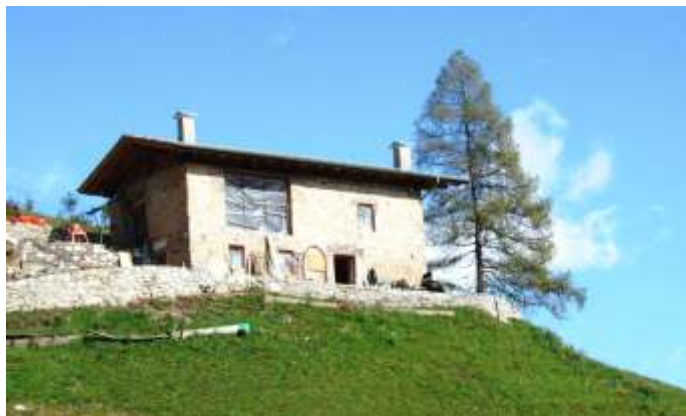
L'antico Mas del Bonéta in ristrutturazione
