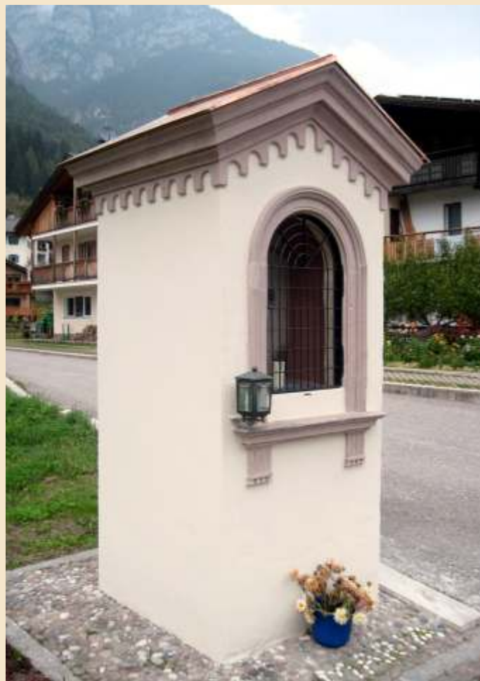
Il capitello di Zanon recentemente ristrutturato
