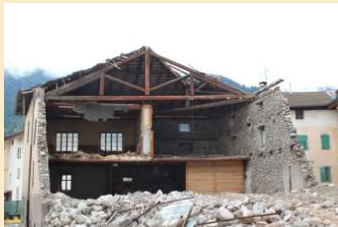
21 ottobre 2013 – Il cantiere è ormai avviato. Gli appartamenti sono già stati demoliti e fra poco anche il Tabià sarà solo un ricordo
