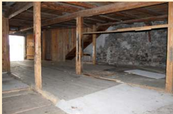
8 ottobre 2013 – Il Tabià è già stato svuotato. Si attende la demolizione
